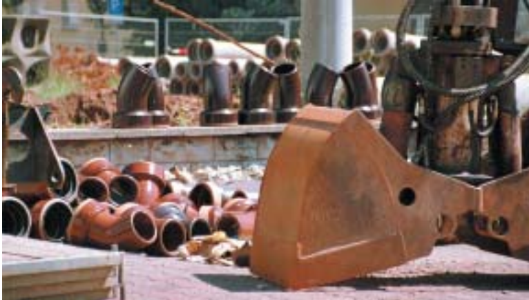
Leitungen, Kabel und Schächte werden im Zuge der Umgestaltung mitsaniert
