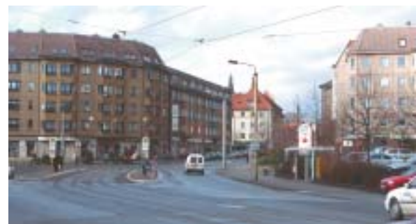
Am Kornmarkt entsteht ein übersichtlicher Kreisverkehr mit integrierter Straßenbahn.
