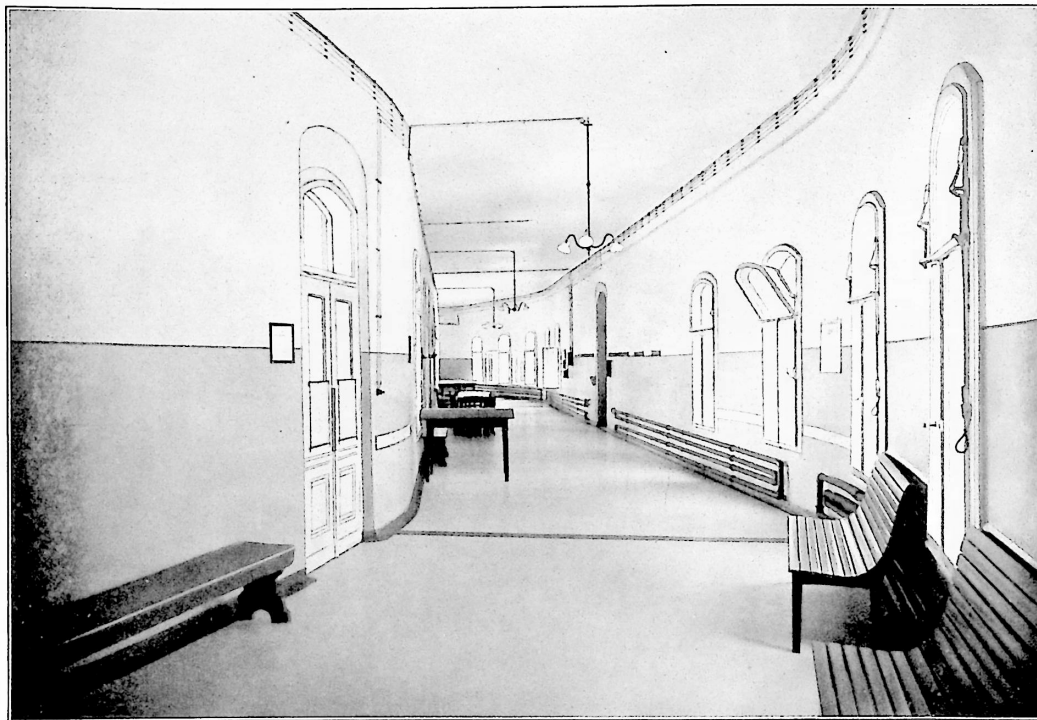
18. Wandelhalle (Tageraum) hinter der oberen Liegehalle.
