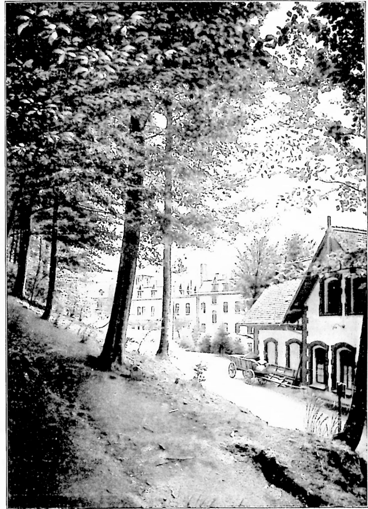
23. Blick auf Arztwohnhaus, Privatanstalt und Stallgebäude vom Park hinter der Heilstätte.
