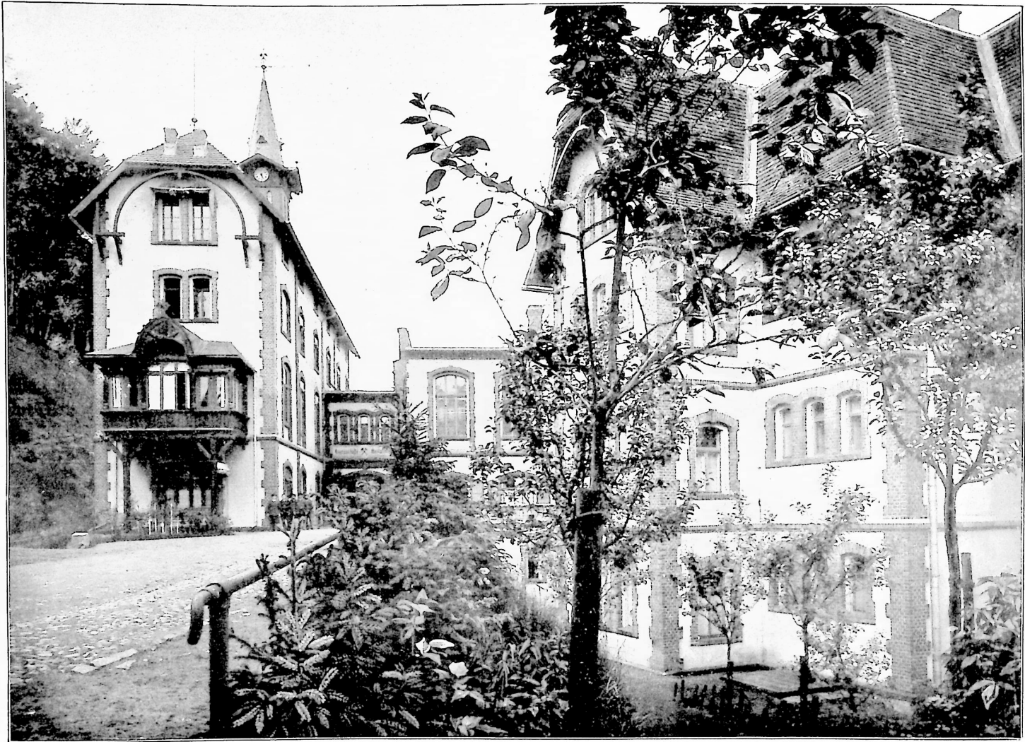
11. Blick vom Arztwohnhaus auf das Wirtschaftsgebäude (mit Schwesternheim), Anrichterraum, Speisesaal und Westflügel.
