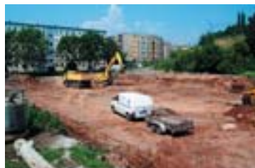
Gründungsarbeiten am Parkhaus Neustadtstraße
