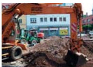
Umfangreiche Tiefbauarbeiten in der oberen Rautenstraße
