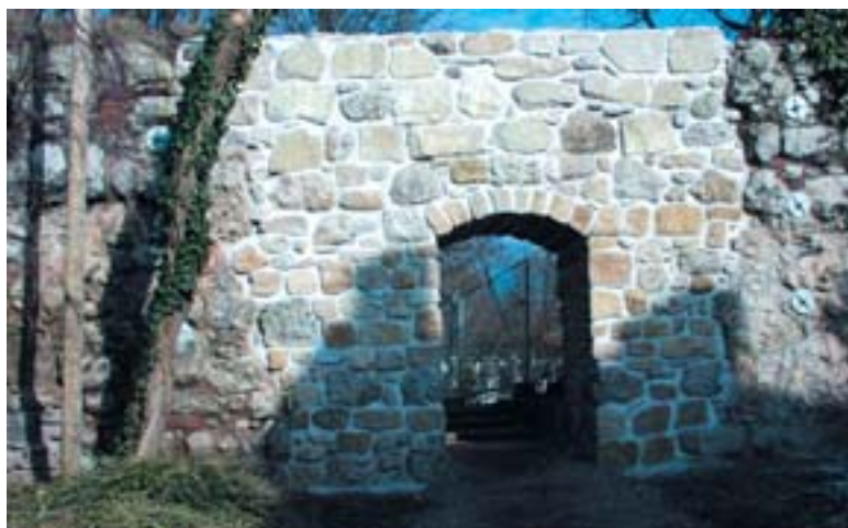
Die Nachtigallenpforte: Vor wenigen Tagen begann die Restaurierung.
