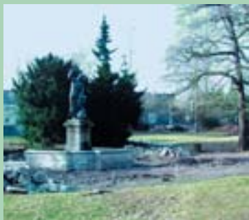
Die Restaurierung des Neptunbrunnens hat begonnen.
